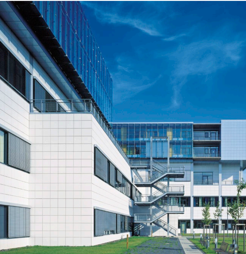
Uniklinik Krankenhaus · University hospital, Marburg, Deutschland · Germany / Architekt · Architect: Eggert & Partner, Stuttgart, Deutschland · Germany / Photo: Michael Meschede
