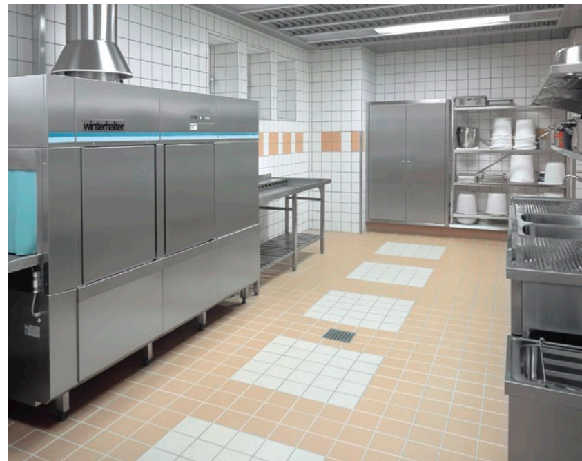
Hans-Prinzhorn-Klinik · Hans Prinzhorn Clinic, Hemer, Deutschland · Germany Architekt · Architect: Realisation GmbH, Frau · Ms. Daniel-Schrodt
