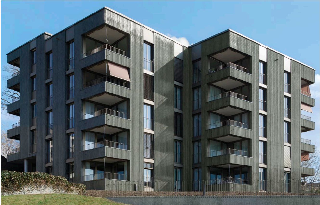
Alterswohnhaus Sonnenhof · Sonnenhof residential nursing home, Wil, Schweiz · Switzerland Architekt · Architect: Meier Hug Architekten, Zürich · Zurich, Schweiz · Switzerland / Photo: Adriano Faragulo
